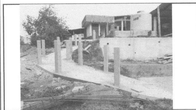
Foto 3: Fase intermedia rampa con barranda
