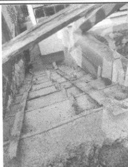
Foto1: Gradas lateral del muro perimetral
