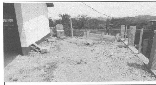
Foto 6: Terreplen del suelo al llegar altura de muro perimetral.
