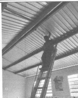
Foto 2: Reparación de la energía eléctrica
