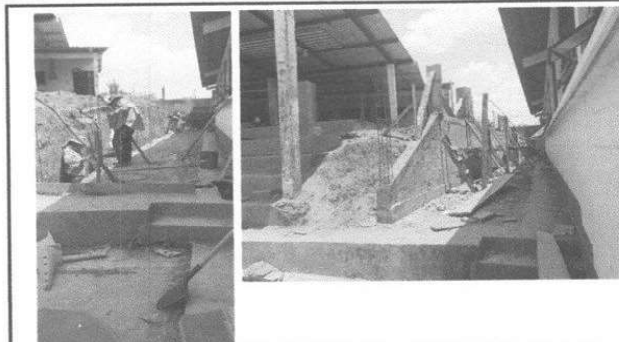
Foto 2: fase intermedia muro perimetral
